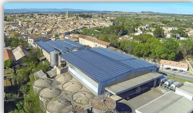
Exemple de grandes toitures photovoltaïques : Cave coopérative, Montagnac
