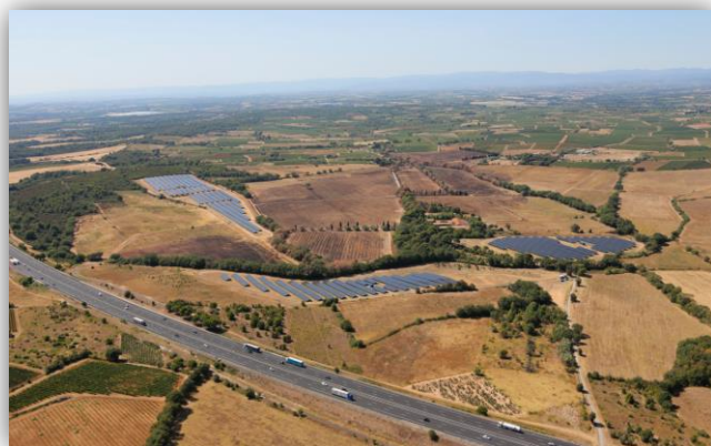
Exemple de centrale photovoltaïque au sol : La Valmale, Bessan
