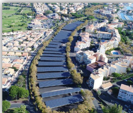
Exemple d'ombrières photovoltaïque : Parking Coquilles, Cap d'Agde
