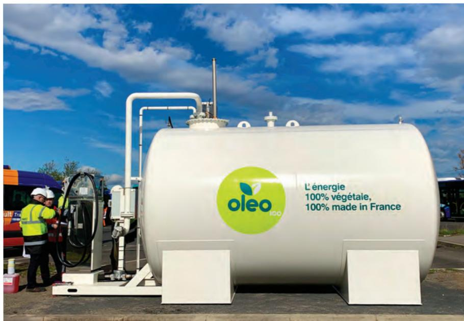
Une cuve Oleo 100 de 20 000 litres a été installée sur le dépôt de kéolis Agde pour permettre l'approvisionnement des bus.
