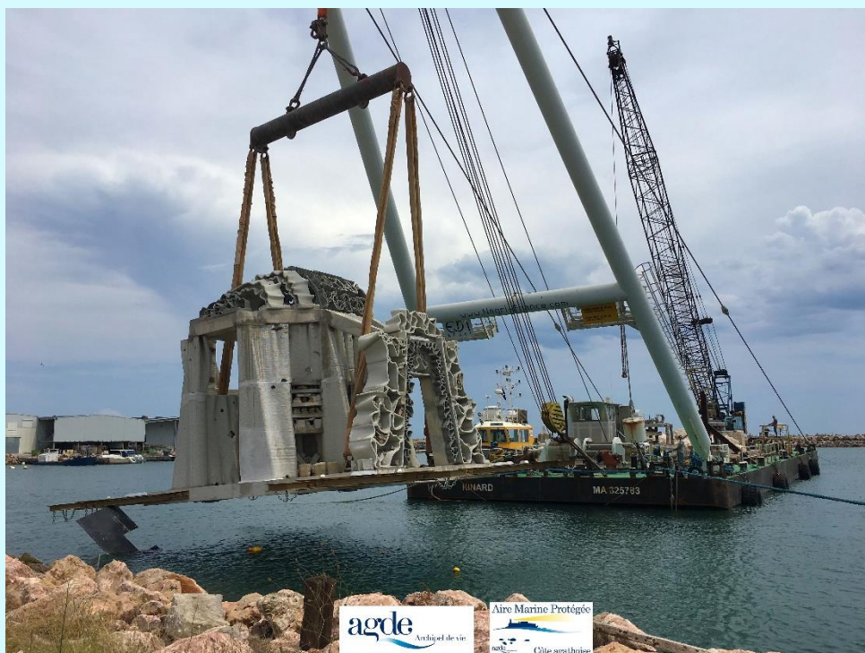
Barge servant de support au village de récifs pour l'immersion
