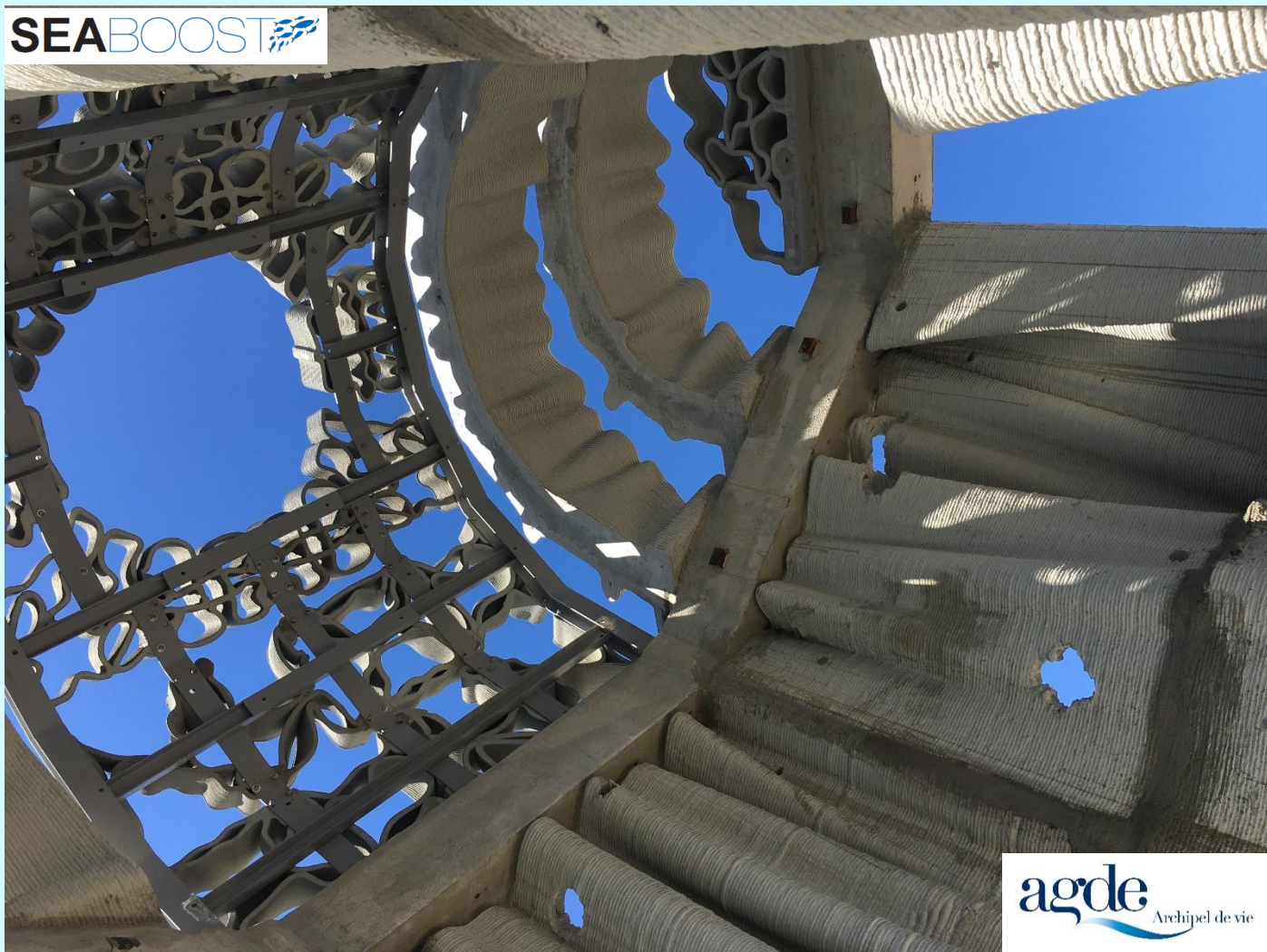
Détail du dôme 3D du récif principal par lequel les plongeurs pourront entrer dans la structure Photo AMP Côte agathoise / ville Agde / R.Dupuy de la Grandrive
