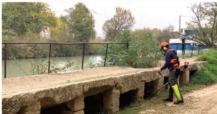
L'Agglo assure l'entretien et le nettoyage des épanchoirs situés aux abords du Canal du Midi. Les équipes interviennent 3 fois par an pour débroussailler et enlever les rejets de végétaux afin de faciliter l'écoulement des eaux, en cas de fortes pluies.
