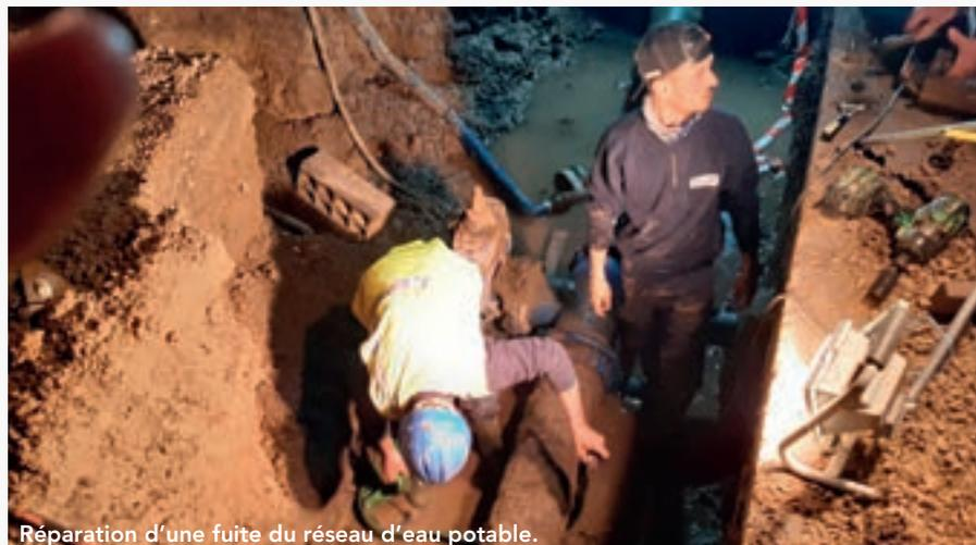
Réparation d'une fuite du réseau d'eau potable.
