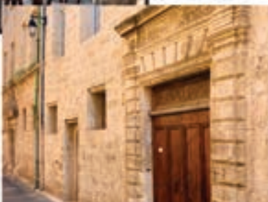
À Montagnac, les grandes familles ont construit des hôtels particuliers.
