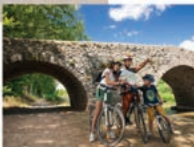
Le Canal du Midi et ses ouvrages d'art, ici le pont Saint-Joseph
