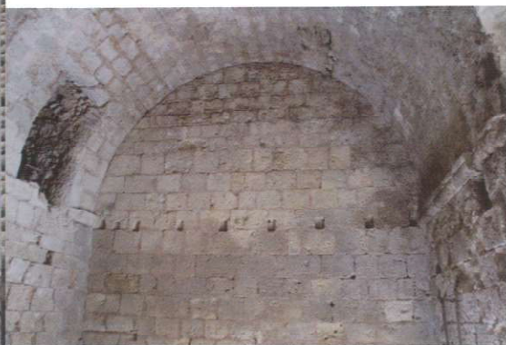
Voûte, trous de poutres et bandeau
