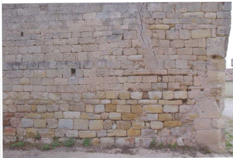
Mur en grès en élévation sur 1,30m Chapelle castrale vue sud-ouest
