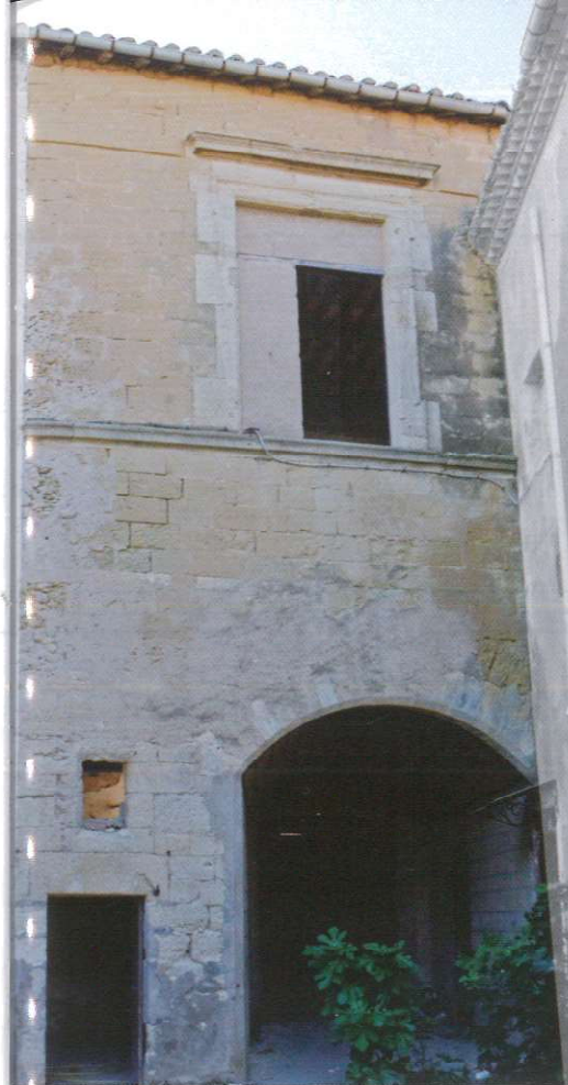
Façade ouest du château
