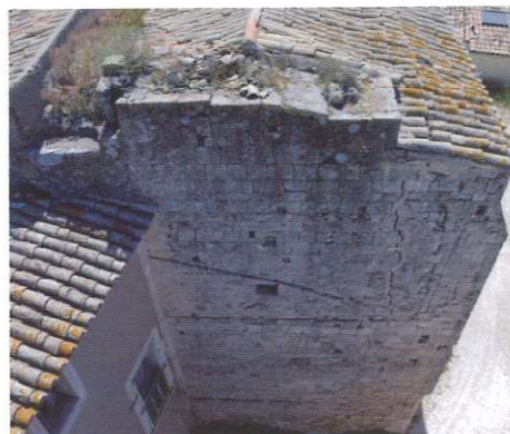
Sommet du mur - clocher
