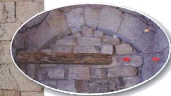
Mécanisme de renfort de la porte médiévale
