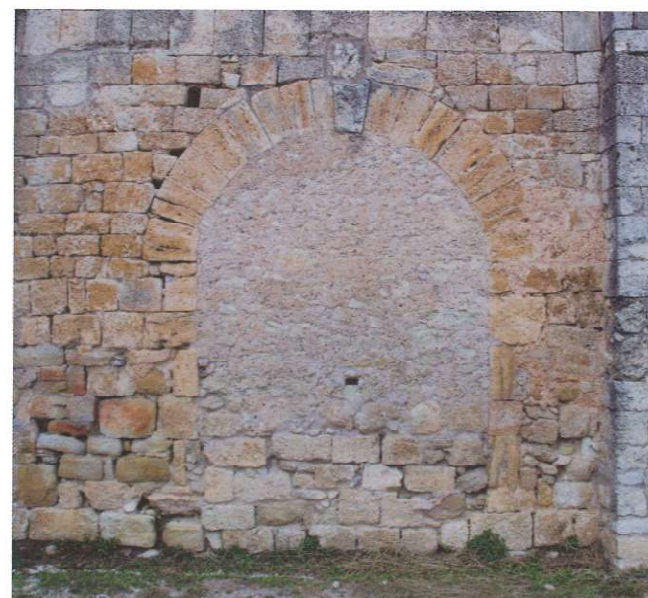
Porte voûtée plein cintre murée
