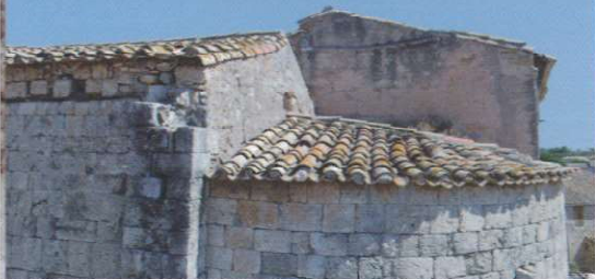
Vue du toit de l'abside et du mur sud du château
