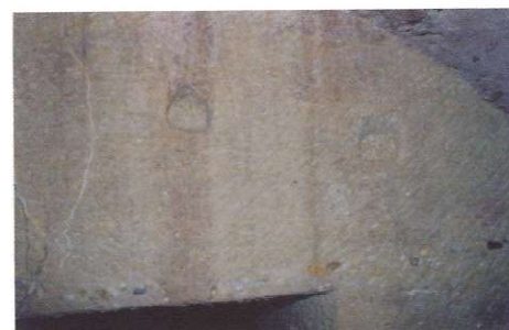
Emplacement de poutres
