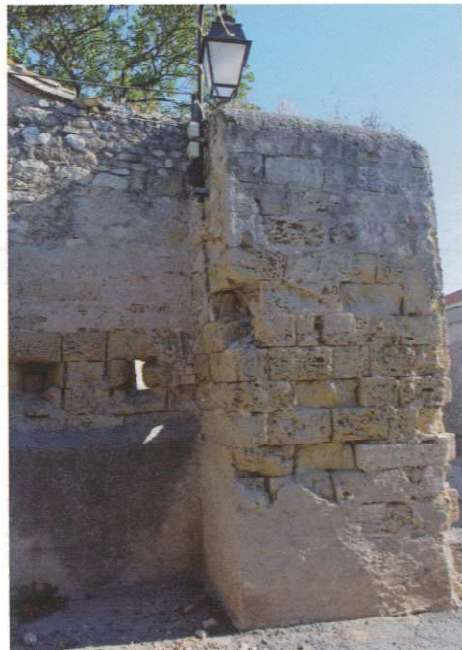
Pilier droit du portail
