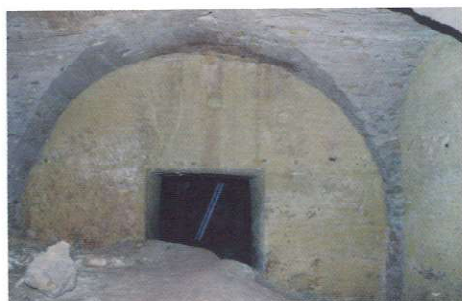
Le passage vers la salle 1
