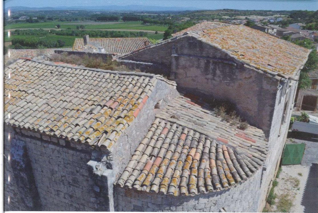
Forme arrondie (parement interne de la tour, ornée d'un bandeau quart de rond) visible sur le mur sud du château
