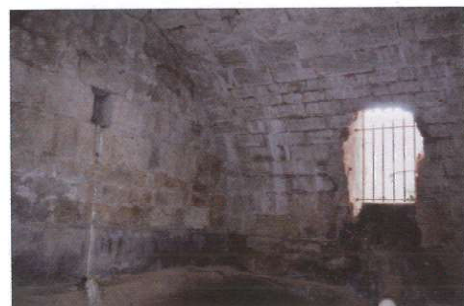
Vue de la citerne voûtée
