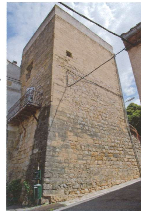
La tour sud-est
