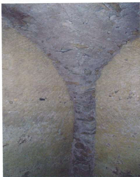
Détail d'une voûte maçonnée
