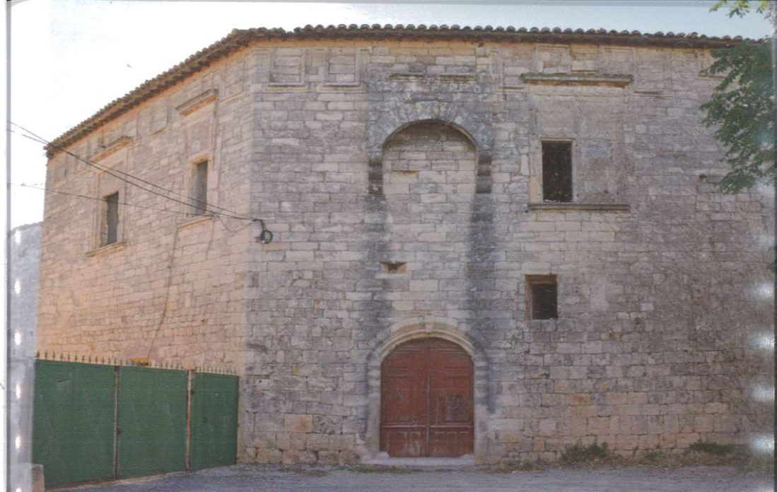
Façade antérieure du château
