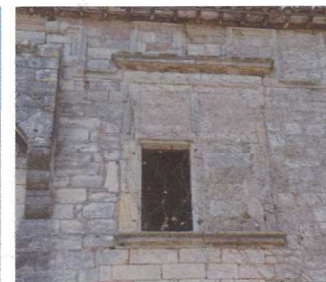
Fenêtre à meneaux nord-est
