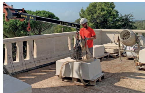
Les corniches ont été reprises.
