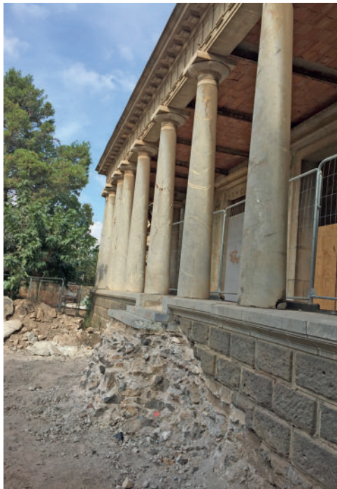
L'escalier a été déposé pour être restauré.
