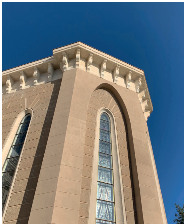
Le parement de la façade du salon de musique a été entièrement rénové.
