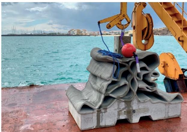
Au cœur de l'Aire Marine Protégée de la Côte Agathoise, 32 micro récifs artificiels réalisés par impression béton 3D ont été immergés pour le baliser la zone des 300 mètres. Ces installations ultra-innovantes remplacent les anciens systèmes de balisage de la zone de baignade (bouée/chaîne/pneu bétonné) qui abîment les fonds marins.
