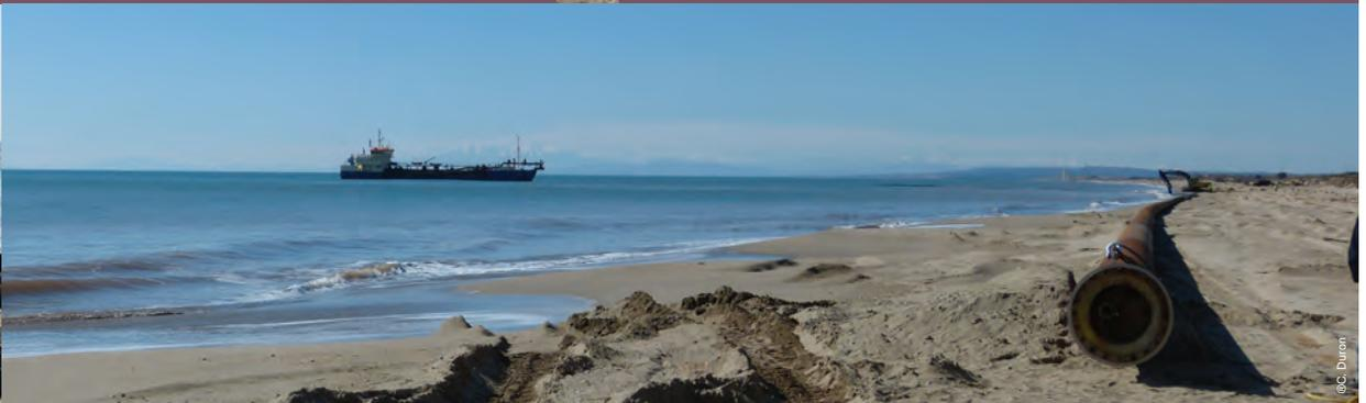
La drague aspire le sable en mer et le transporte sur site. Le bateau se connecte à la conduite pour refouler le sable
