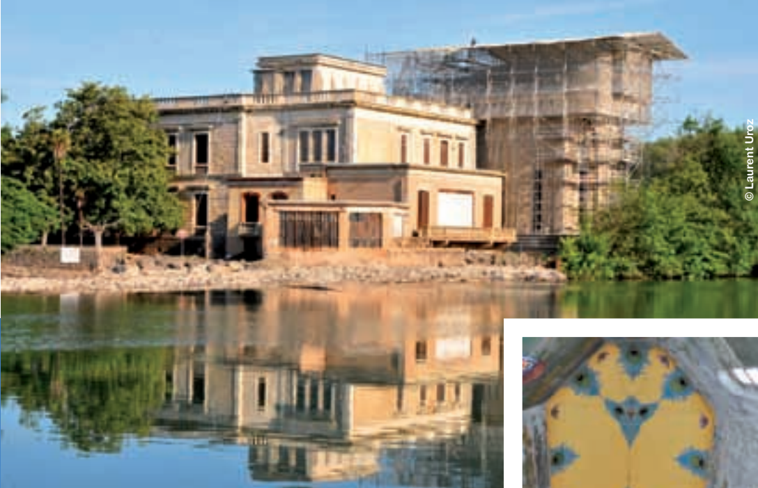
Près d'un an de travaux ont été nécessaires pour rénover la toiture en écaille de zinc du Château Laurens
