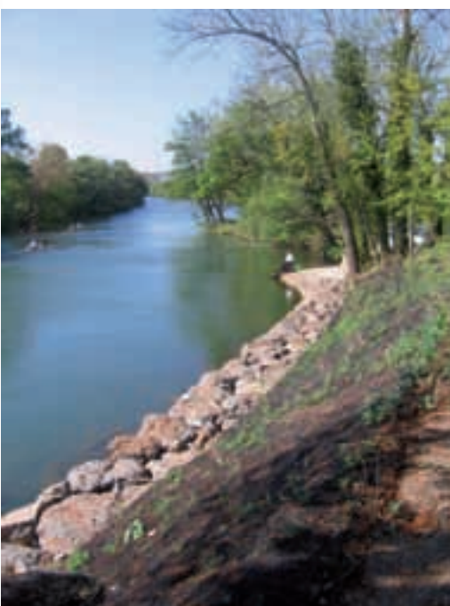
Stabilisation de la berge à Bessan
