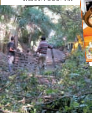
Chantier PLIE à Florensac
