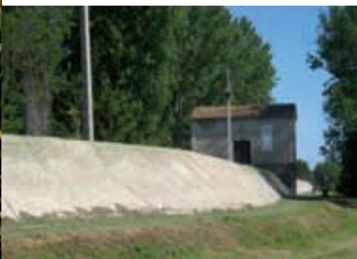
Réfection de la digue de Cazouls-d'Hérault
