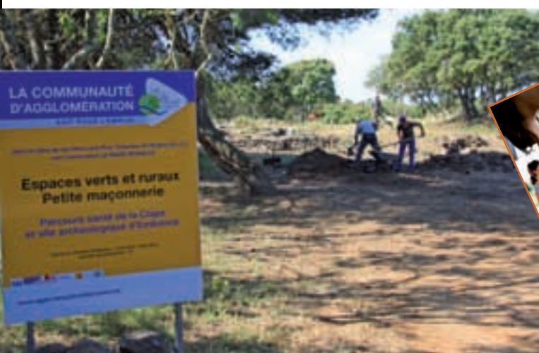
Chantier PLIE au Cap d'Agde
