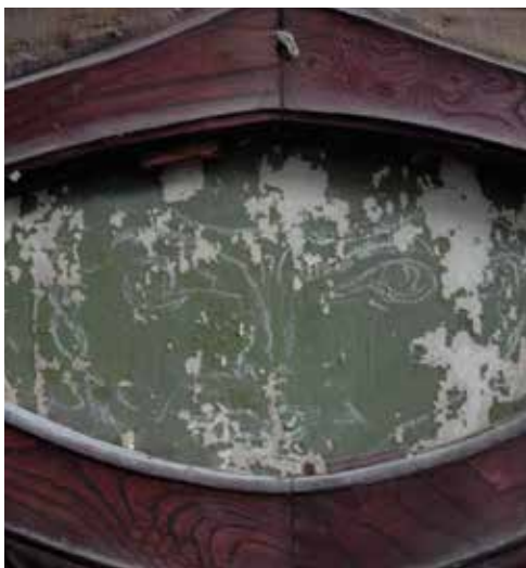
Panneau de lambris et détail avant travaux.
